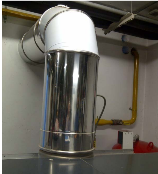
Ilustración 4: Salida de humos de Caldera
