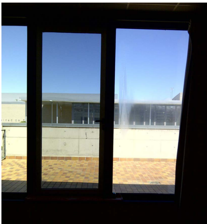
Ilustración 16: Ventana del aula con acumulación de condensado debido a la elevada humedad de la sala.
